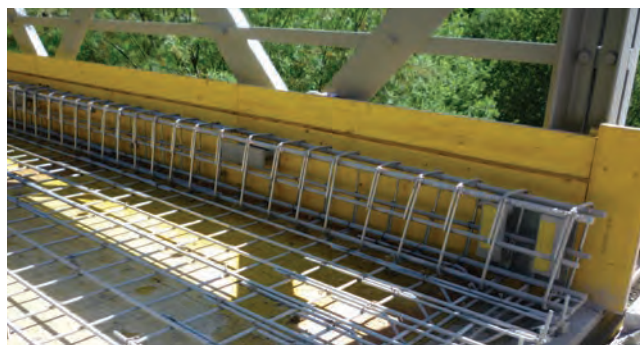
Blacktenbrücke, Bauma, Schweiz
