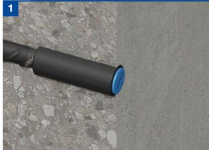
Der Betonstahl wird mit vormontierter Kupplung auf die Baustelle geliefert und mittels Nagelteller an der Schalung fixiert.
