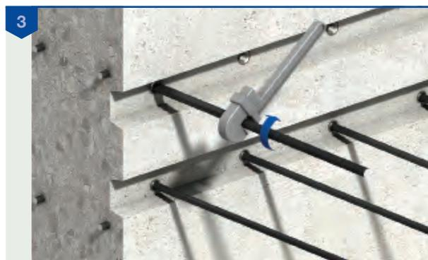
Die KSN-Anker dürfen nur in Verbindung mit von uns bezogenen CXL-Anschlussstäben verwendet werden.
