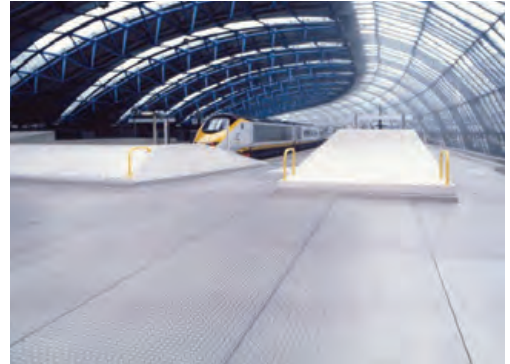
Projekt: Waterloo International Terminal, GB
