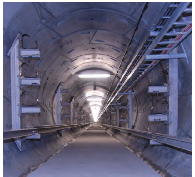
Projekt: Kabeltunnel City West, Australien (Bauherr: Energy Australien, Ausführendes Unternehmen: Theiss, Bauleitung: Maunsell/Aecom)
