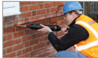
3. Benutzen Sie das Helifix Auspressgerät um eine Schicht HeliBond- Mörtel an der Rückseite des Schlitzes aufzutragen
