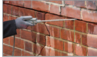
2. Reinigen und spülen Sie die Schlitz mit Wasser bis das Mauerwerk ausreichend befeuchtet ist
