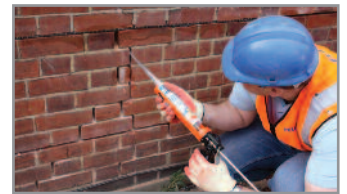
6. Verputzen Sie die Mörtelfuge und füllen Sie den vertikalen Riss mit CrackBond TE3 auf
