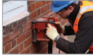
1. Schneiden Sie Schlitz in das horizontale Mörtelbett, mindestens 500mm beidseitig der Risse
