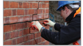
4. Drücken sie einen HeliBar Stab in den Mörtel um eine gute Einbindung zu erhalten. Verwenden Sie dazu das HeliBar Werkzeug
