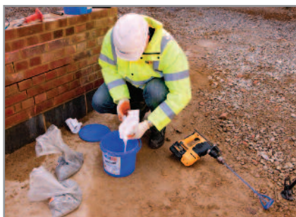
1. Schütten Sie das Paket mit der Flüssigkeit in den mitgelieferten Eimer.
