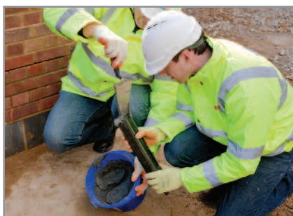
4. Prüfen Sie dass der Kolben fest in das Rohr der Auspresspistole passt (Siehe Anleitung der Auspresspistole) und füllen Sie den Mörtel gleich nach dem Aufrühren in die Auspresspistole.
