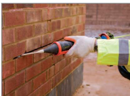
5. Injizieren Sie den Mörtel in einem Durchgang gleichmäßig in den Schlitz oder die Bohrung im Mauerwerk. Die übliche Verarbeitungszeit für den Mörtel im Eimer beträgt ca. 2 Stunden. Die Auspresspistole sollte innerhalb von 5 Minuten geleert werden. Wird der Arbeitsprozess aus irgendeinem Grund unterbrochen, füllen Sie den Mörtel aus der Auspresspistole zurück in den Eimer und rühren Sie diesen noch einmal auf bevor Sie weiterarbeiten.
