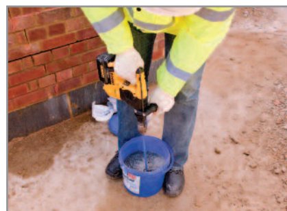
3. Mixen Sie die Komponenten gründlich mit einem elektrischen Mixer durch. Mischen Sie nicht mit der Hand, da das Ergebnis meist inhomogen ist.
